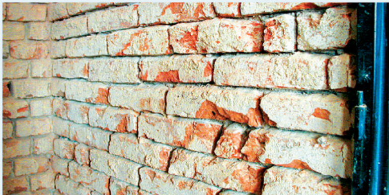
Dobře připravené zdivo
