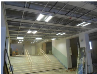
Vestibul v průběhu rekonstrukce
